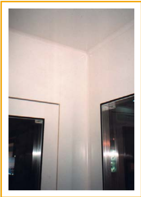
Pyöreänurkkainen seinä/seinäliitos katto/seinäliitos
