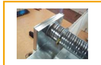
6. Ilmakanaali elementin sisällä
