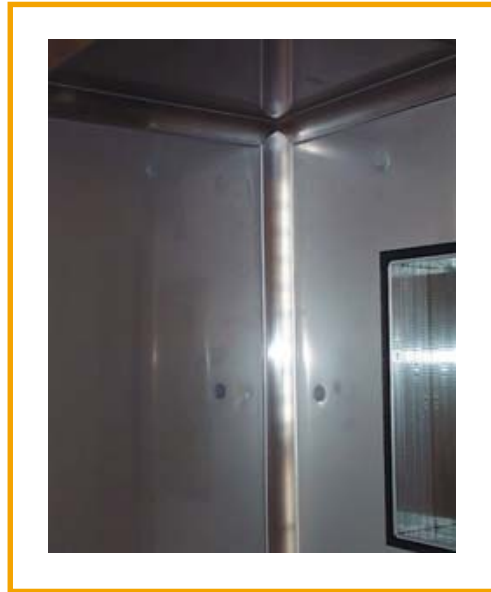
Pyöreänurkkaisen huoneen mallinurkkaus katosta kuvattuna.
